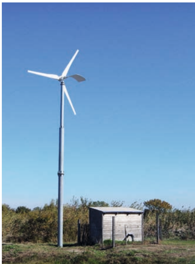
La station de pompage présente sur le site du Cassaïre permet la gestion de l'eau. La pompe est alimentée par l'énergie éolienne qui assure son autonomie en énergie.
